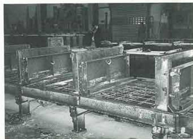
L形擁壁型枠
