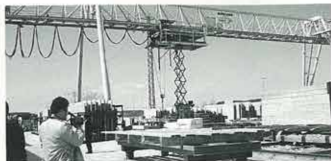
マシントリークレーン
