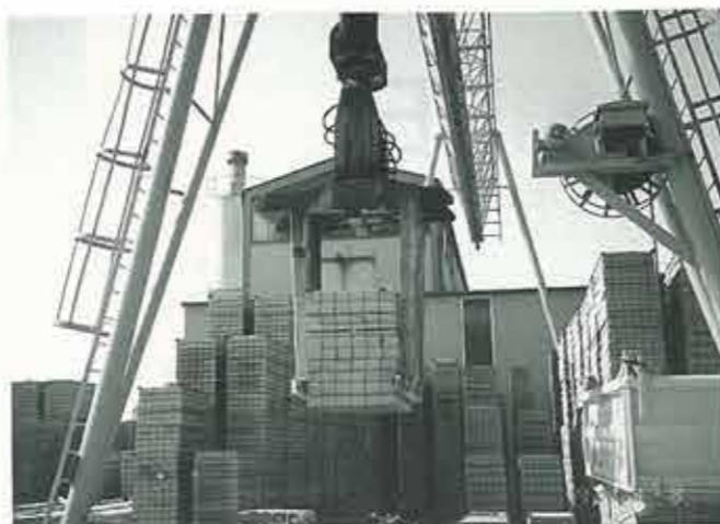
製品吊り込み
