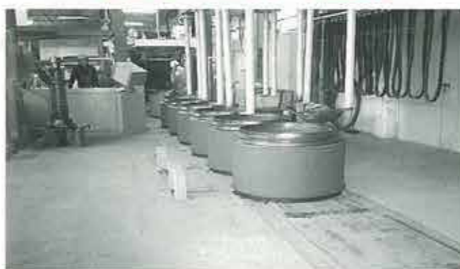
即脱マンホール
