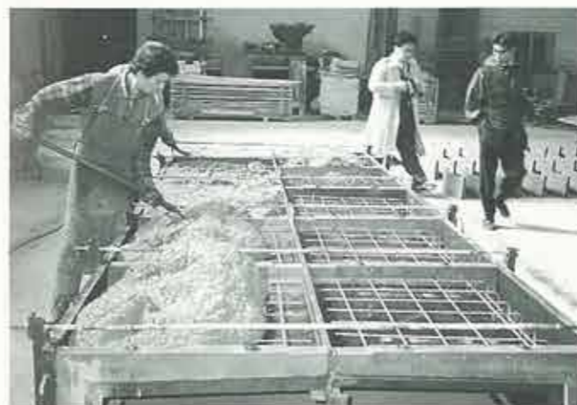
流し込み製品の打ち込み
