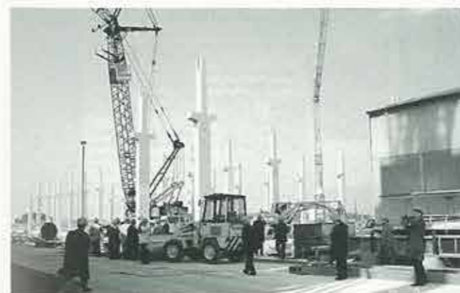
自社製品による新工場増設現場
